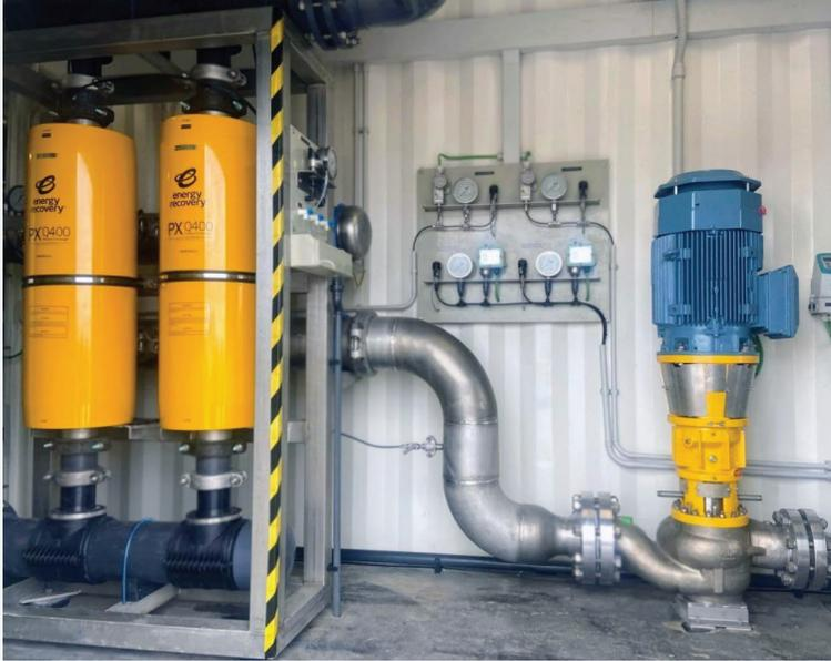
Para alcanzar los ambiciosos objetivos de rendimiento de DESALRO 2.0, ITC recurrió a Energy Recovery, Inc. y a su intercambiador de presión Q400 PX®, una solución de eficacia comprobada para reducir el consumo energético en plantas de desalinización.
